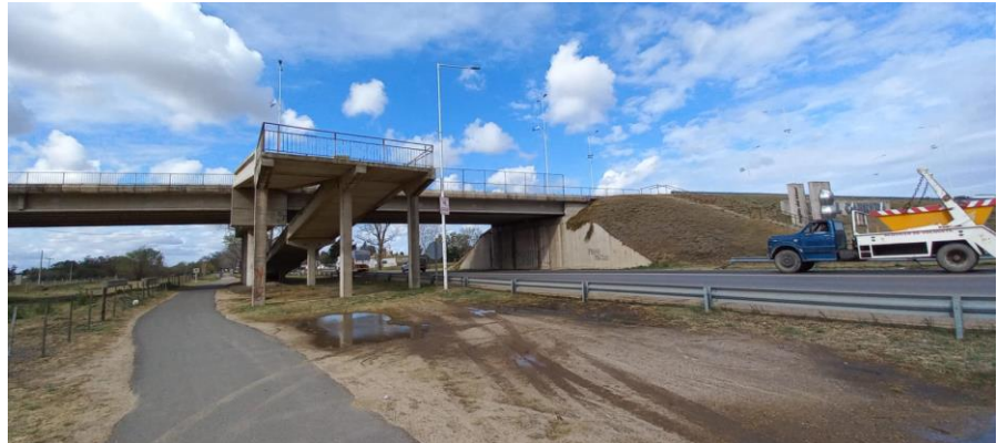
IMAGEN 4 – Bicisenda existente sur en el ingreso a la localidad.
